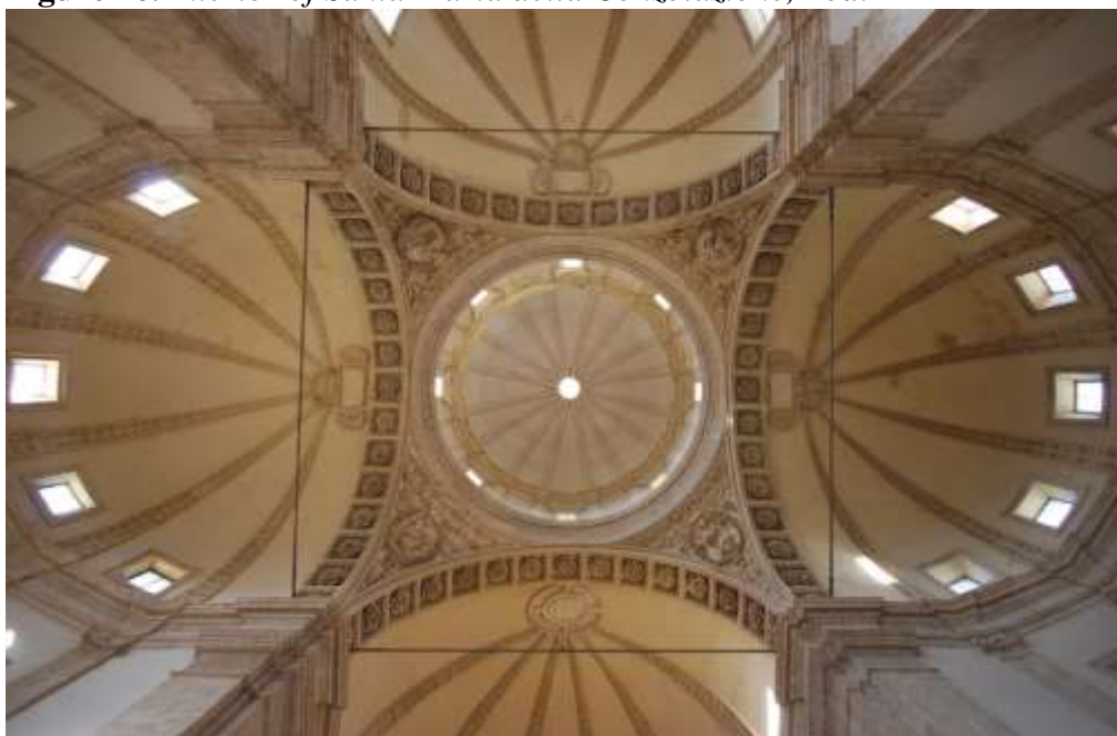
Figure 16. Interior of Santa Maria della Consolazione, Todi
