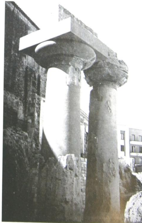
Fig. 10. SIRACUSA: Artemision. Le colonne dopo il restauro.
