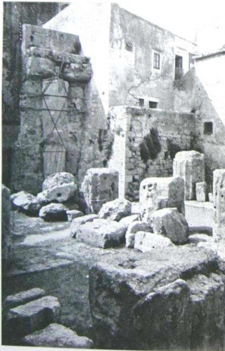
Fig. 9. SIRACUSA: Artemision. Le colonne prima del restauro.
