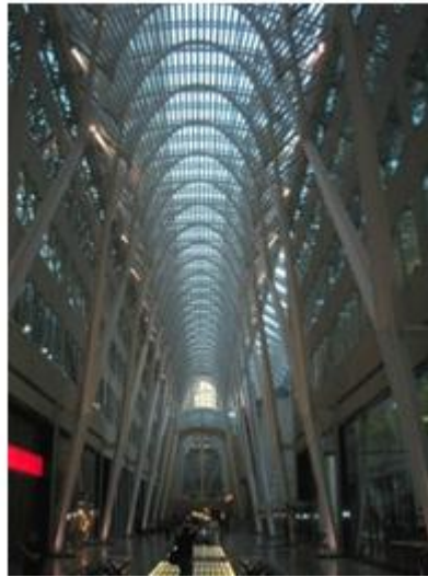
Figure 27. Stuttgart Airport, Terminal 3, Stuttgart (Meinhard von Gerkan, 2004)
